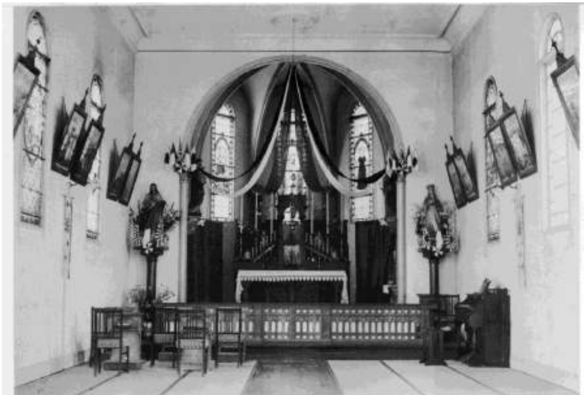
昭和42年まで建っていた、仙台で明治の記念すべき建軸とされていた北五十人町教会の内部。
